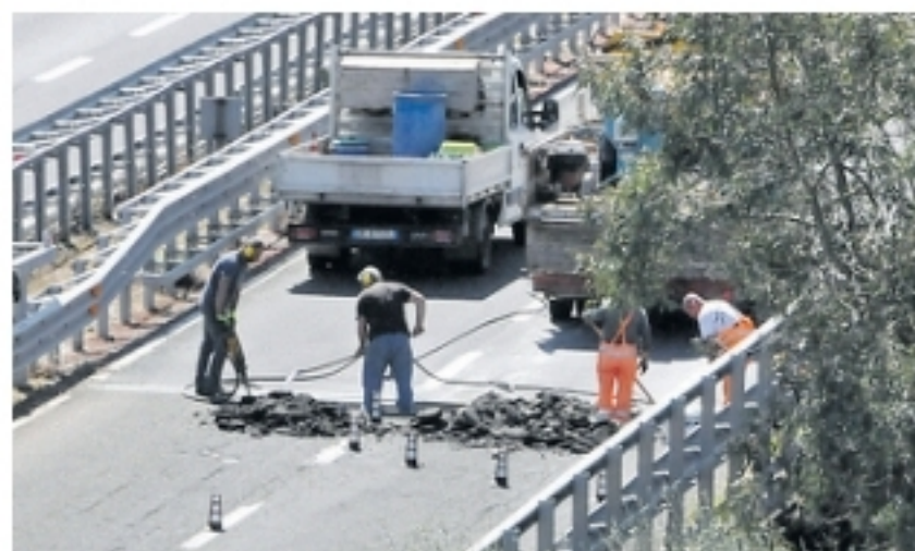
Operai Anas in un cantiere
